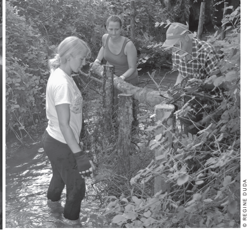
Pour donner plus de structures au ruisseau, des bénévoles enfoncent des pieux dans son lit (à gauche). Ils enfoncent des racines et des grosses branches entre les pieux.
