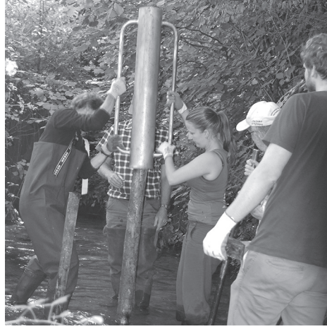
Pour donner plus de structures au ruisseau, des bénévoles enfoncent des pieux dans son lit (à gauche). Ils enfoncent des racines et des grosses branches entre les pieux.
