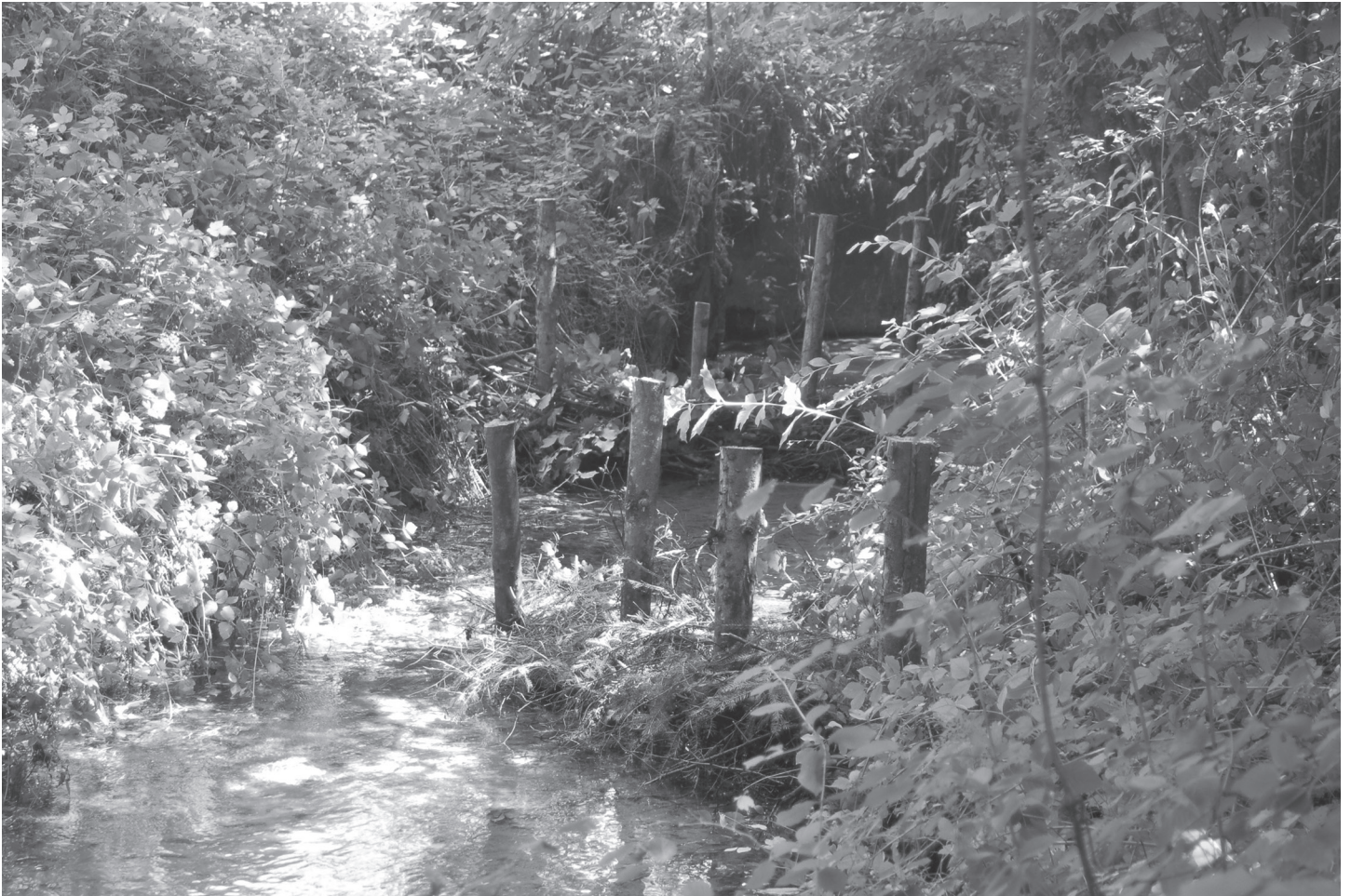
Les biefs réalisés subdivisent le lit de la rivière en plusieurs zones, qui sont autant d'habitats. © Regine Duda
