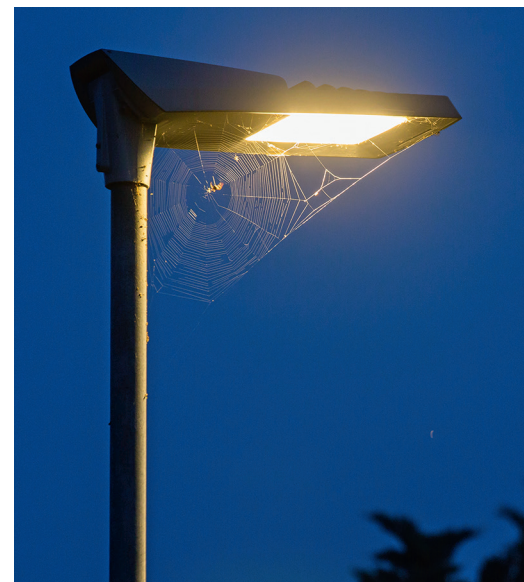
Wartung ist bei LED-Laternen nicht notwendig, hingegen muss man sie regelmässig reinigen. © S.A.F.E.
