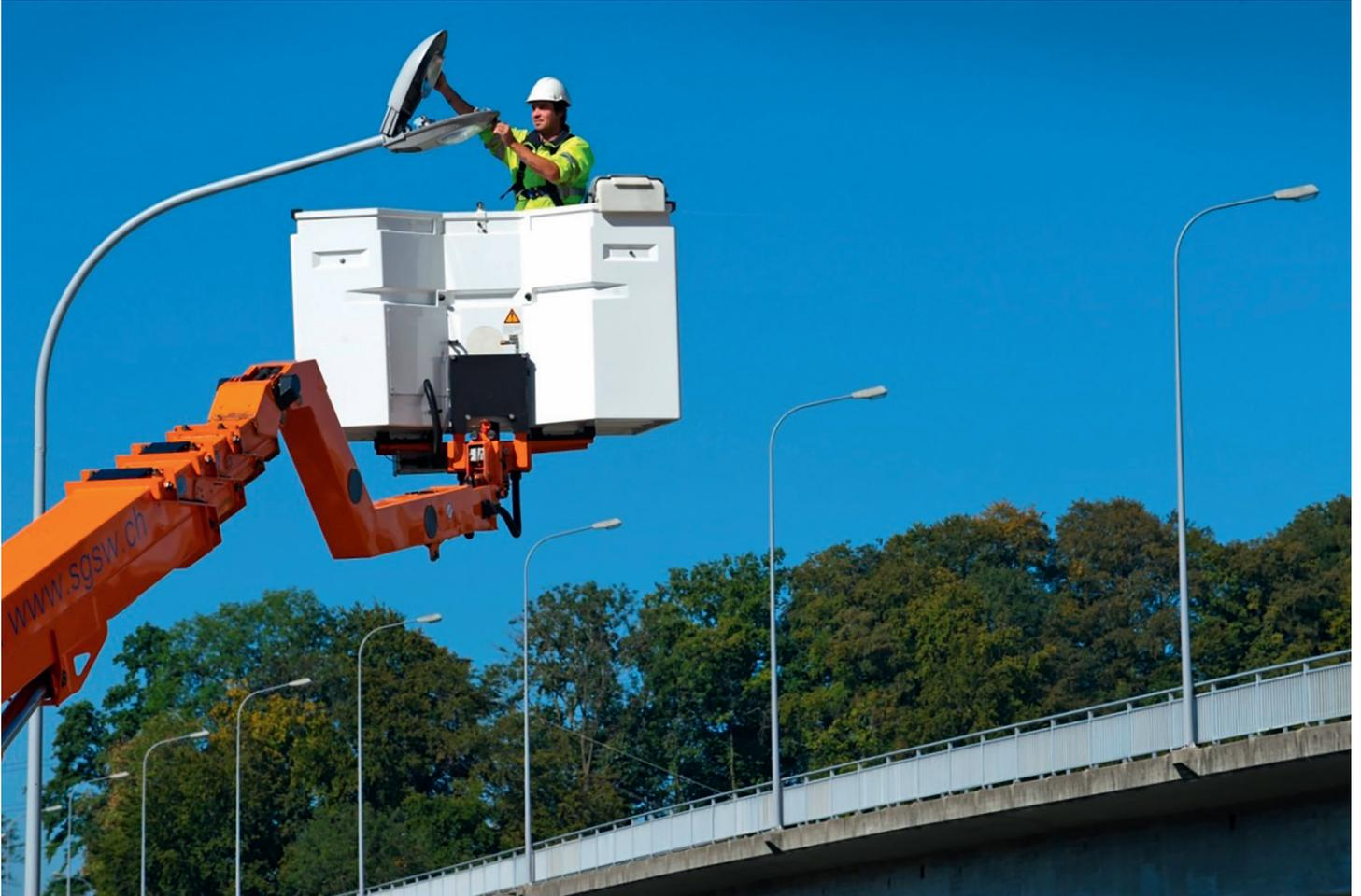
*Allein durch die Umstellung auf LED-Leuchten mit intelligenter Steuerung kann 75-95% an Energie eingespart werden. © S.A.F.E.*
